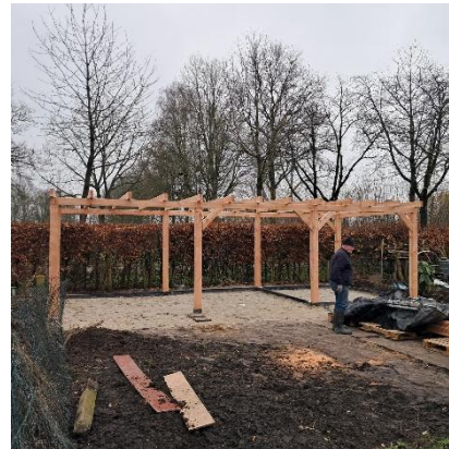
Het skelet van het gebouw
